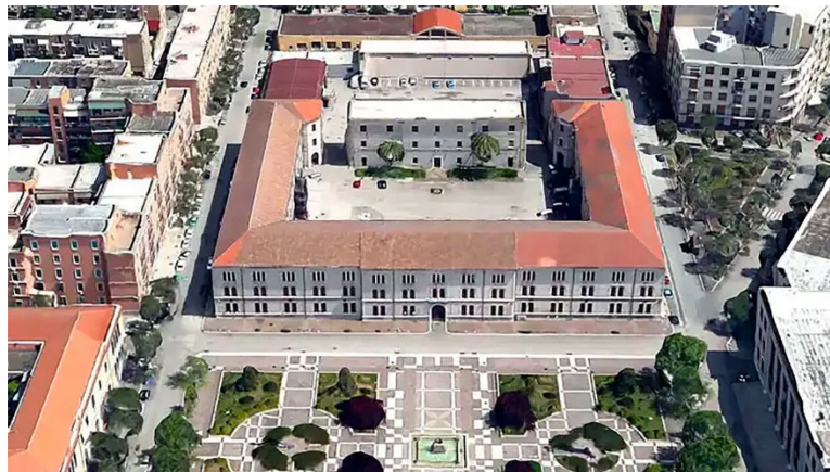
Figura 2 - Vista aerea frontale "ex Caserma Miale"
